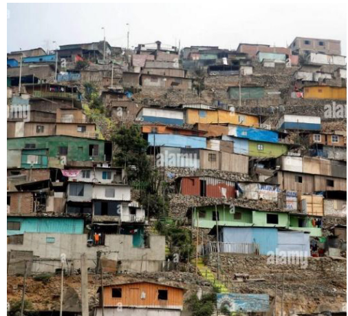
Casa de Pamplona Alta.- Fuente: Alamy
